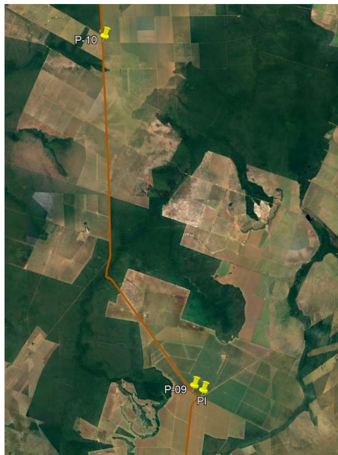
Figura 2-3: Parte inicial do acesso local ao sítio do aproveitamento (Fonte: Google Earth)
