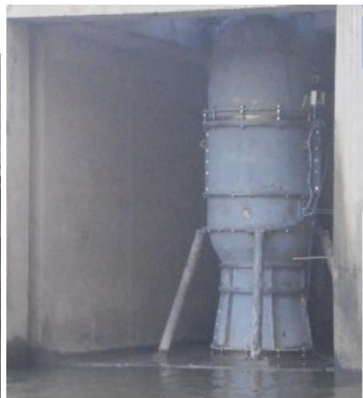
Figura 11-8: Turbina tipo hélice instalada no barramento de uma PCH (Fonte: VERKA)
