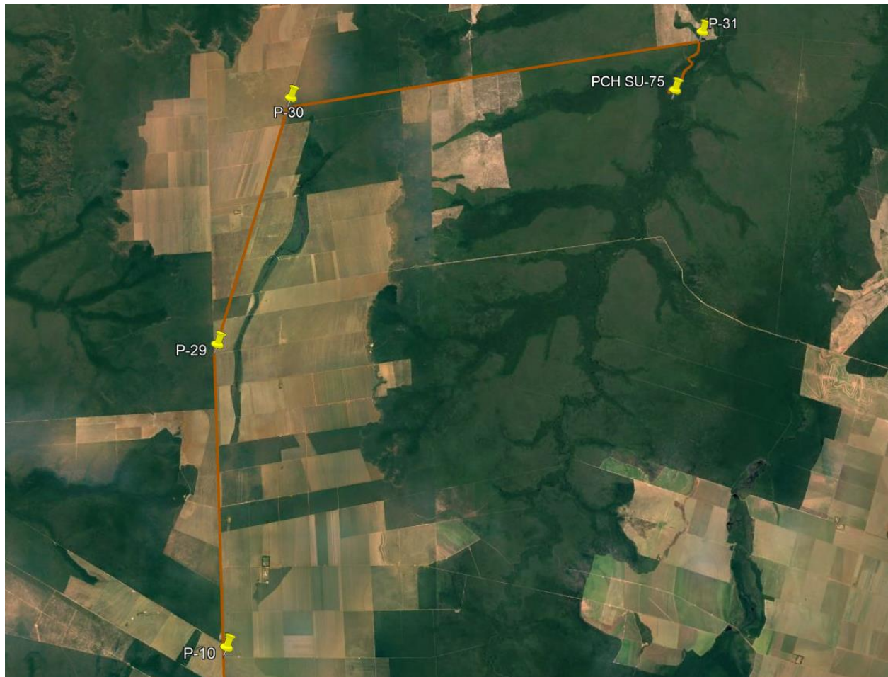
Figura 2-4: Trecho final do acesso ao sítio do aproveitamento (Fonte: Google Earth)
