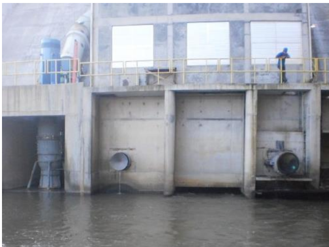
Figura 11-8: Turbina tipo hélice instalada no barramento de uma PCH (Fonte: VERKA)
