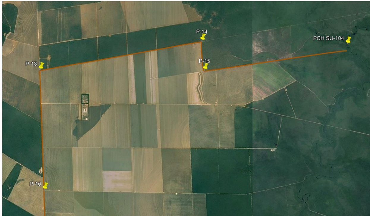
Figura 2-5: Acesso ao sítio do aproveitamento pela margem esquerda do rio (Fonte: Google Earth)
