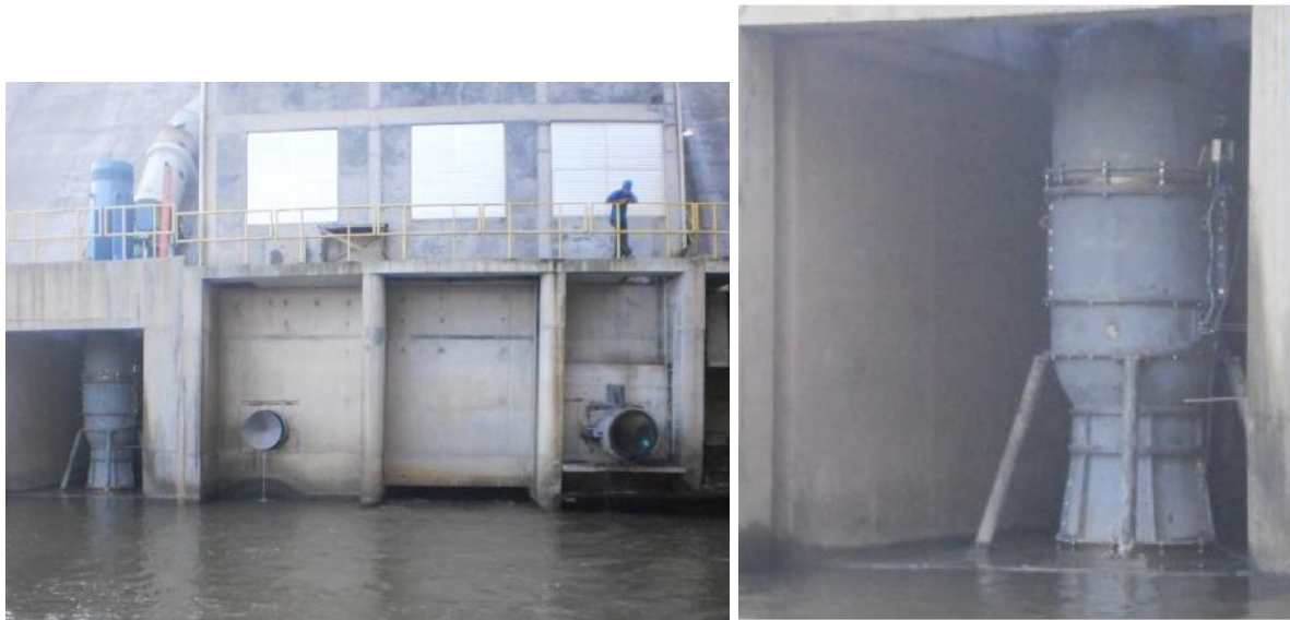
Figura 11-8: Turbina tipo hélice instalada no barramento de uma PCH (Fonte: VERKA)
